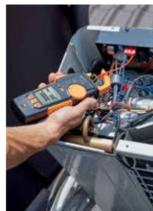
Подвешивание токоизмерительных клещей к наружному блоку холодильной установки.
