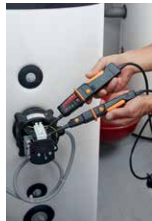
Измерение напряжения на бойлере.
