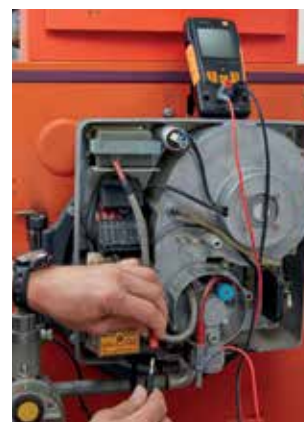
Подготовка к измерению тока ионизации.
