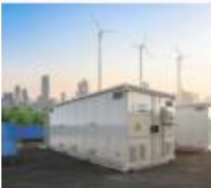
Тестирование EPC Тестирование в поле для хранения энергии (аккумуляторная батарея)
