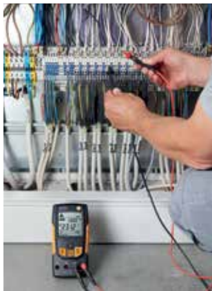
Проверка напряжения в распределительном щитке.
