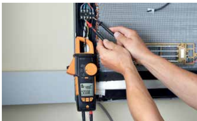
Измерение напряжения на блоке кондиционера с testo 770 .
