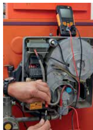
Подготовка к измерению тока ионизации.
