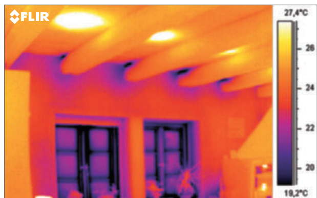
На термическом изображении видны тепловые мосты между балками перекрытия и смежными стенами.
